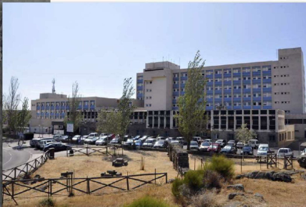
Hospital Virgen del Puerto. Plasencia
